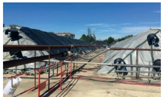
Une opération exemplaire de dépollution sur site : ancien site Stronglight Saint-Etienne Chateaufort - Un réseau d'extraction (venting) récupère les polluants sous forme gazeuse et liquide pour être ensuite épurés
